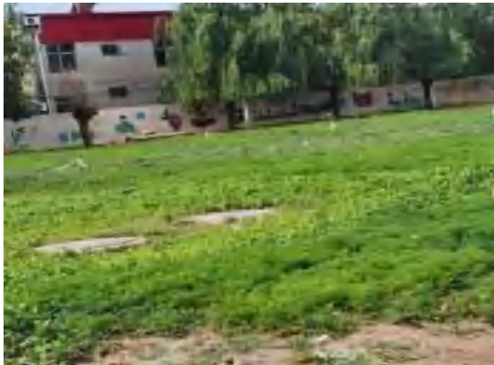
地下泵房井口
