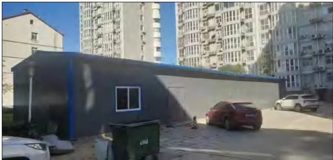
照片3.3-6 温泉花园换热站
