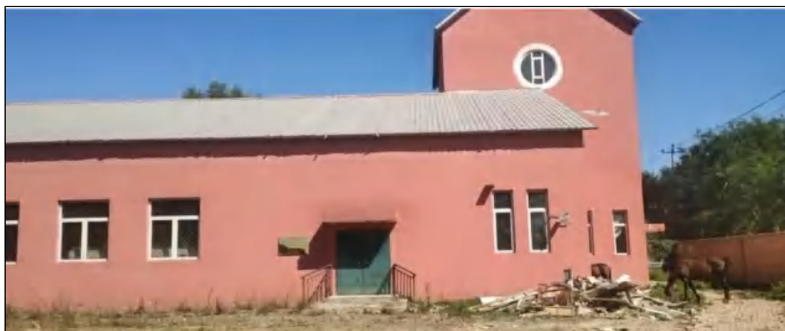
照片1.3-1 R5井室
