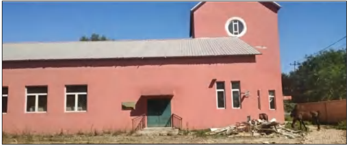
照片3.3-1 R5井室
