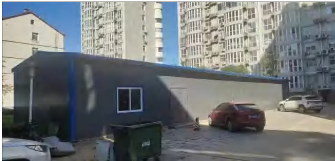
照片1.3-6 温泉花园换热站
