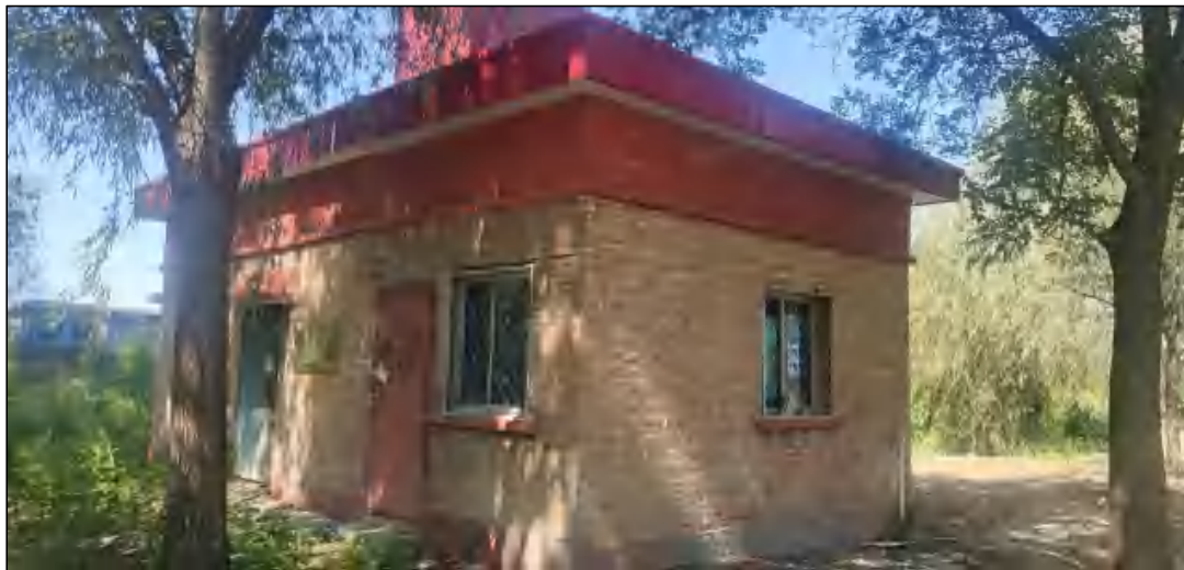
照片1.3-4 R3井室
