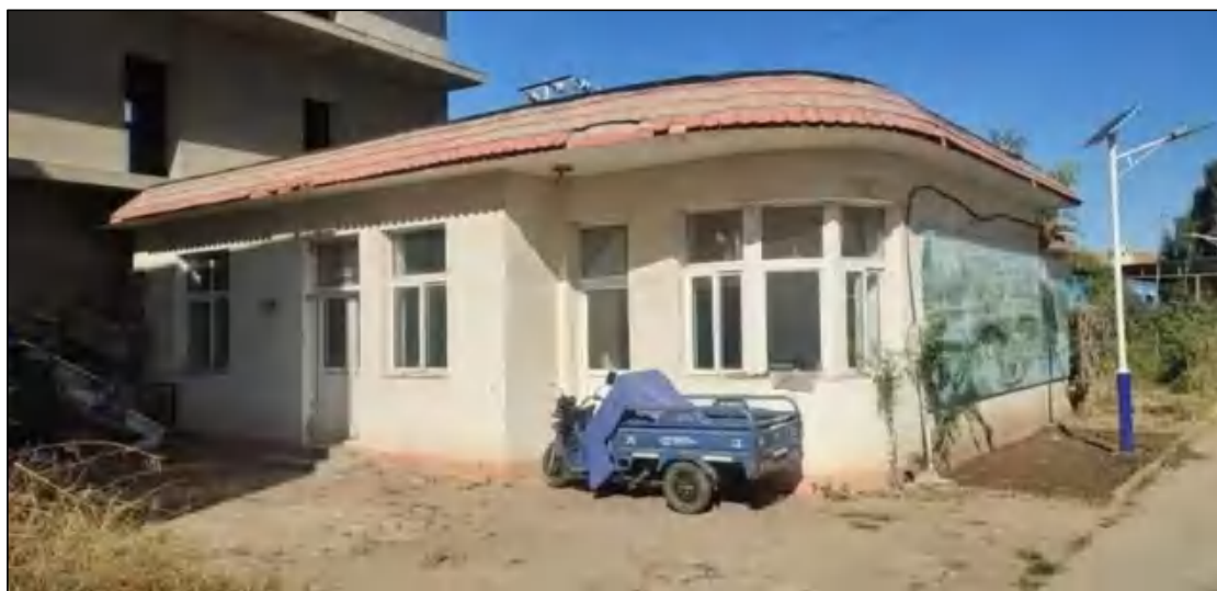
照片3.3-8 商业街换热站
