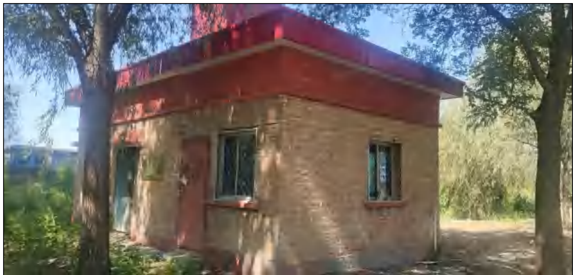
照片3.3-4 R3井室
