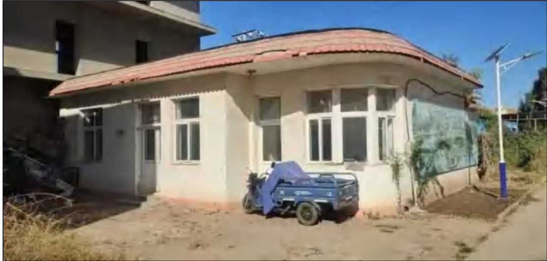
照片1.3-8 商业街换热站
